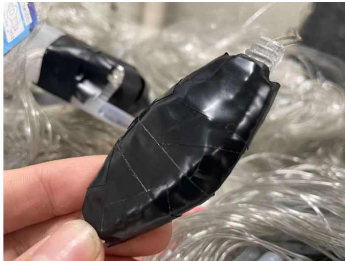
防水処理の様子（同時にはんだ付け不良の修理も実施）
